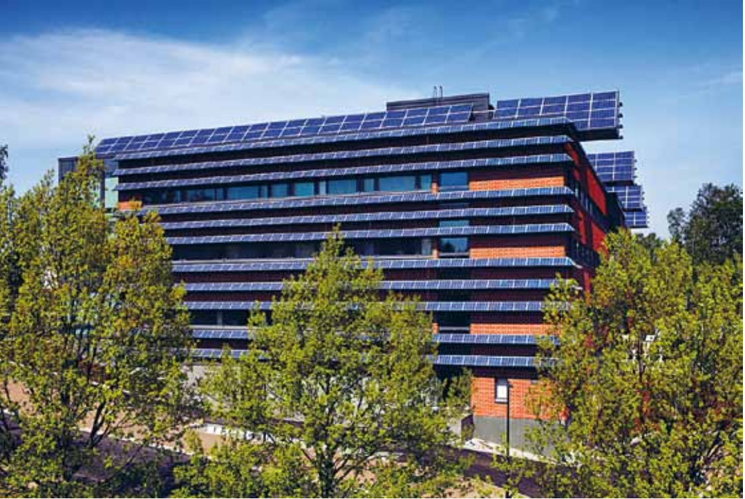
Vaisalan pääkonttori Vantaalla tuottaa yli 700 m 2 :n aurinkopaneeleilla sähköenergiaa noin 100 MWh vuodessa, vastaten 20 prosenttia rakennuksen sähkönkulutuksen tarpeesta. Kuva: Vaisala
